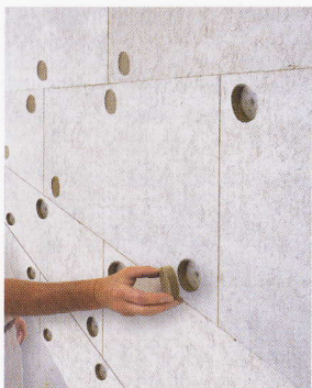
Eine fachgerechte Verdübelung (hier: Dübel-Schema W) ist das A und O.
