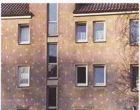
Werden Dübel nicht wärmebrückenfrei oder falsch gesetzt, zeichnen sich die Dübelköpfe an der Fassade ab.
