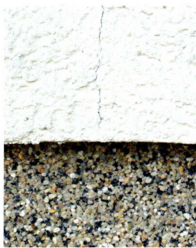
Bei nicht fachgerechter Ausführung des Sockelanschlusses können im Stoßbereich zwischen den Profilen Risse entstehen.
